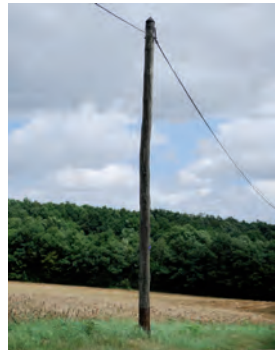
Support d'ancrage en façade, Poteau téléphonique (Source : QU@TREC)
