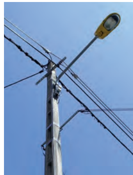
Appui de distribution d'électricité accueillant les réseaux d'éclairage public et de communications électroniques (Photo ARCEP).
