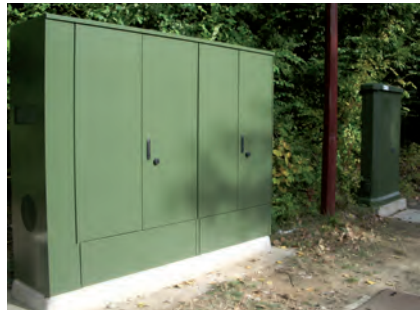
Armoire NRA-ZO avec le sous-répartiteur en arrière-plan (Seine-et-Marne).
