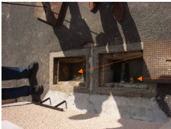
Zoom sur les deux chambres d'adduction du pavillon
