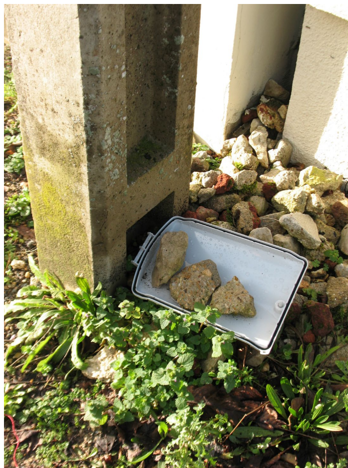
Support de protection du PBO arraché
