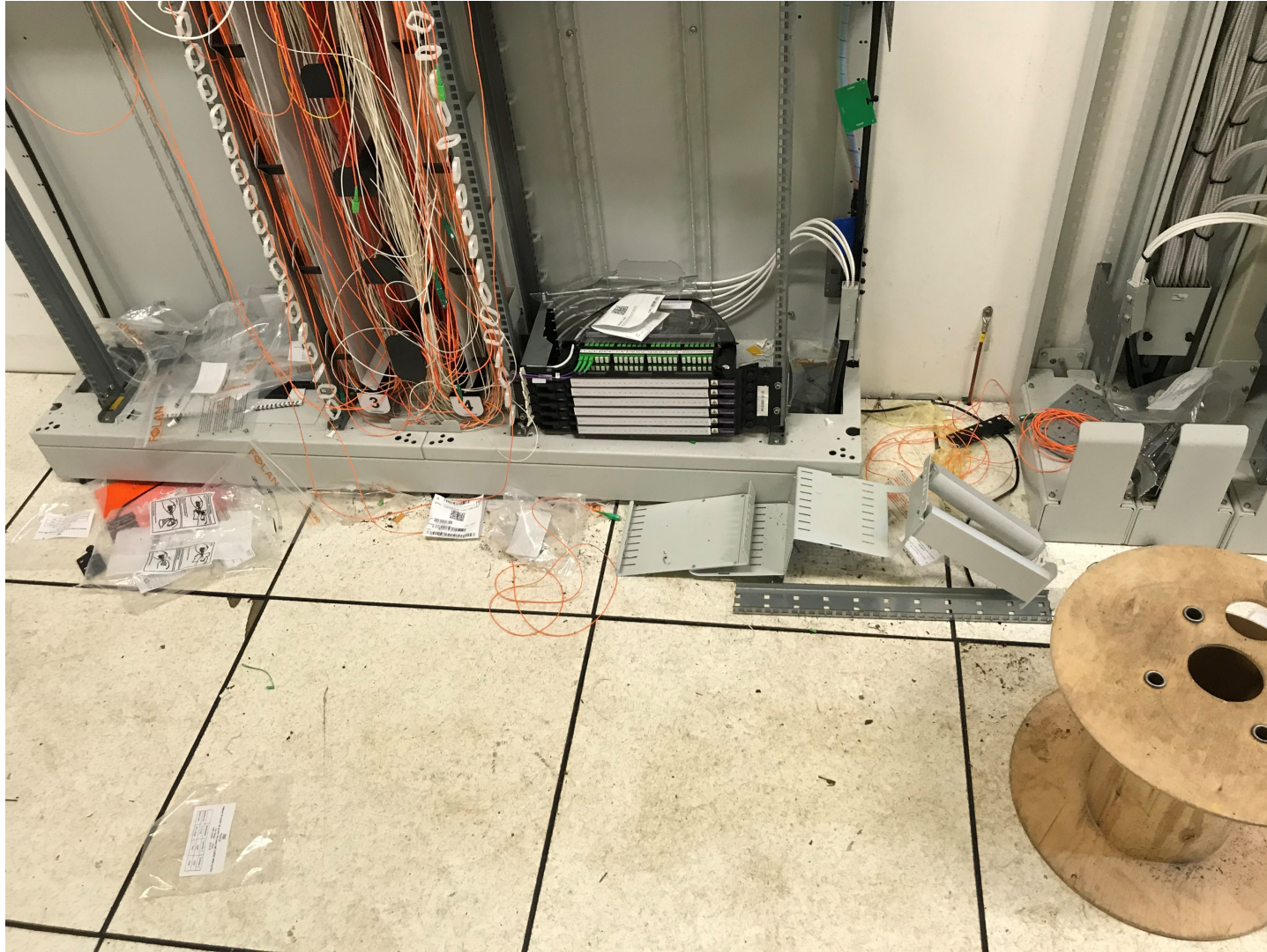
Dégradations à l'intérieur du NRO (au PM)
