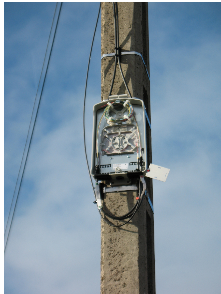
Support de protection du PBO arraché
