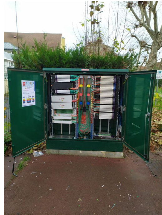
Même PM-SRO après remise en conformité
