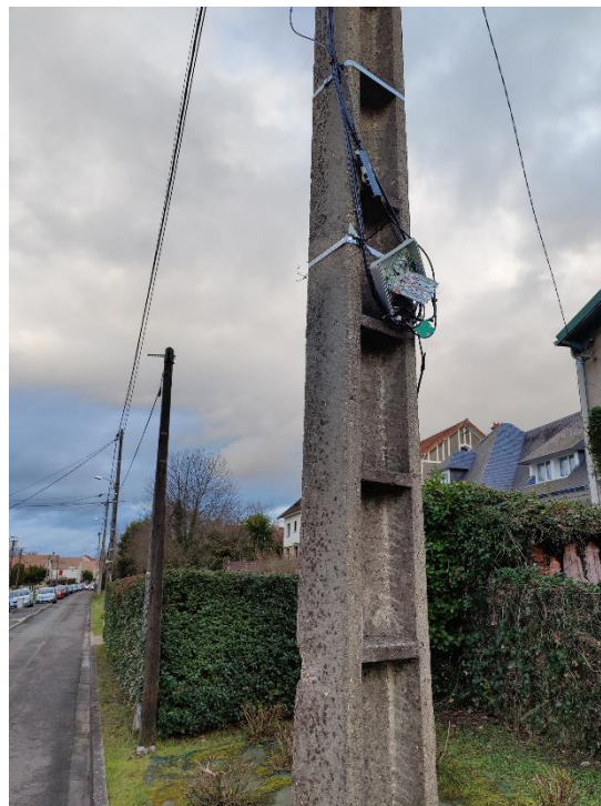
Point de Branchement Optique Arien éclaté
