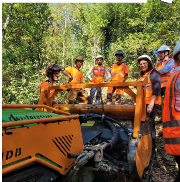
Observation des travaux de débroussaillage, d'élagage et d'armement de poteaux à Gilhac-et-Bruzac (Ardèche).
