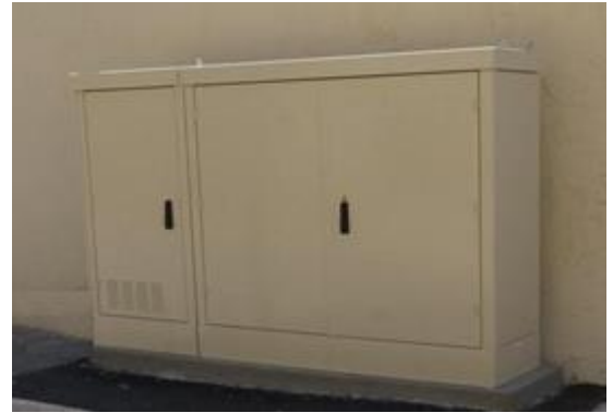
Armoire passive avec élément d'extension actif
