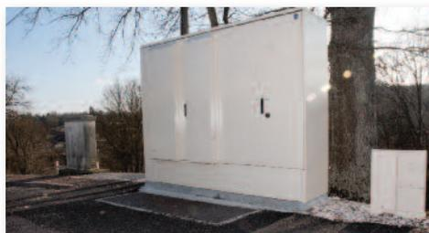
NRA desservant une zone de sous-répartition réaménagée avec le sous-répartiteur en arrière plan et l'adduction électrique au premier plan. La chambre est enterrée devant l'armoire qui héberge les équipements actifs
