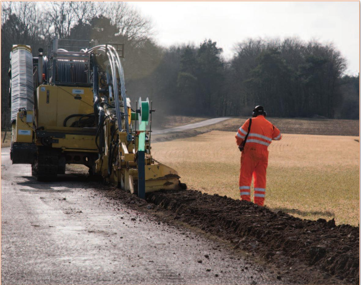
Pose de fourreaux en pleine terre en vue de déployer un réseau en fibre optique.
