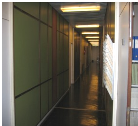
Photo 4 : La zone de bureaux.
