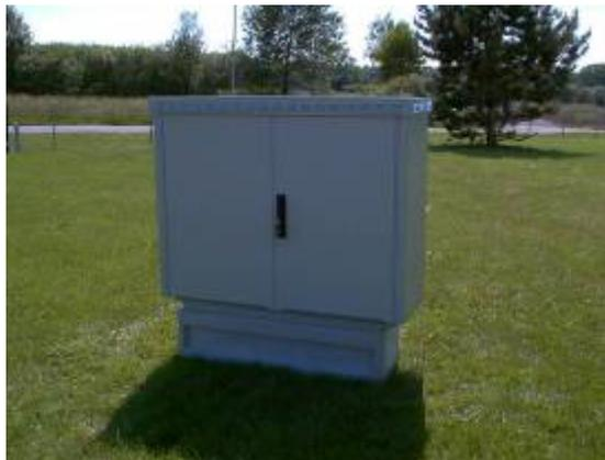
L'armoire est installée sur une dalle béton en extérieur.
