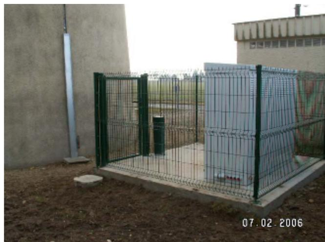
Dans ce cas, la clôture atteint une hauteur hors sol de 2 mètres pour éviter les intrusions. Elle est constituée de poteaux métalliques, d'un grillage et d'un portillon ou d'un portail.
