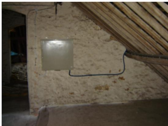
Le coffret ne présente pas de garanties anti intrusion et de fiabilité optimales mais présente l'avantage d'être une solution simple et économique pour l'installation d'équipements électroniques peu sensibles.
