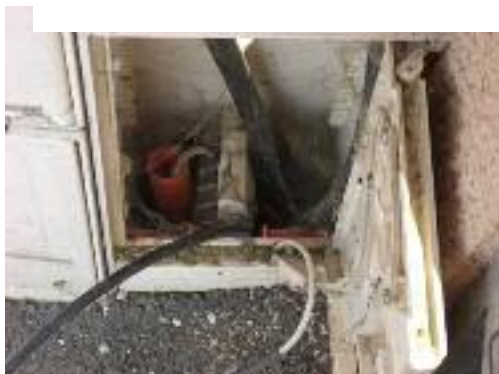
Exemple de coffret EDF avec fourreau de télé-report
