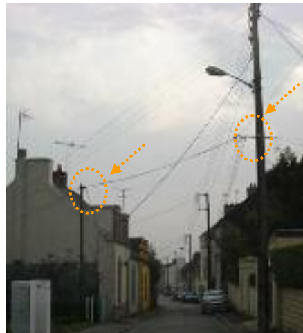
Desserte aérienne uniquement pour le téléphone par appuis métal en propre
