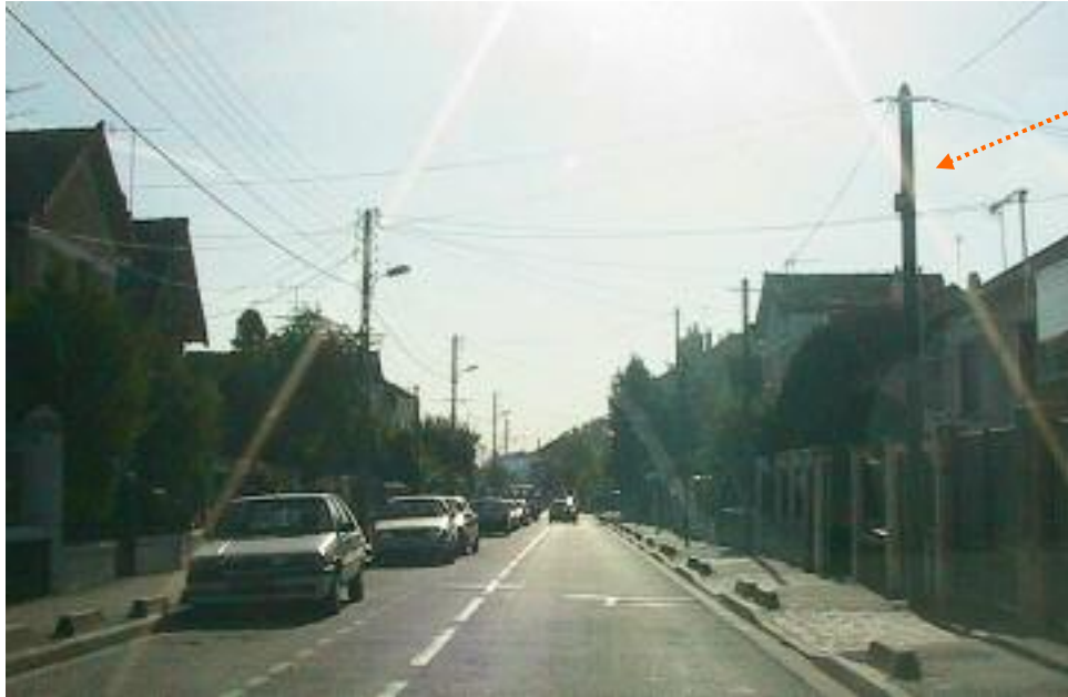
Poteau bois France Télécom
