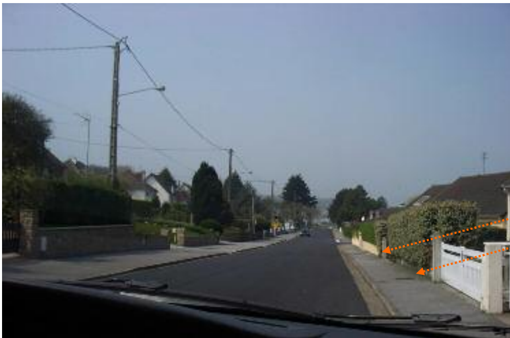
Chambres de raccordement France Télécom
