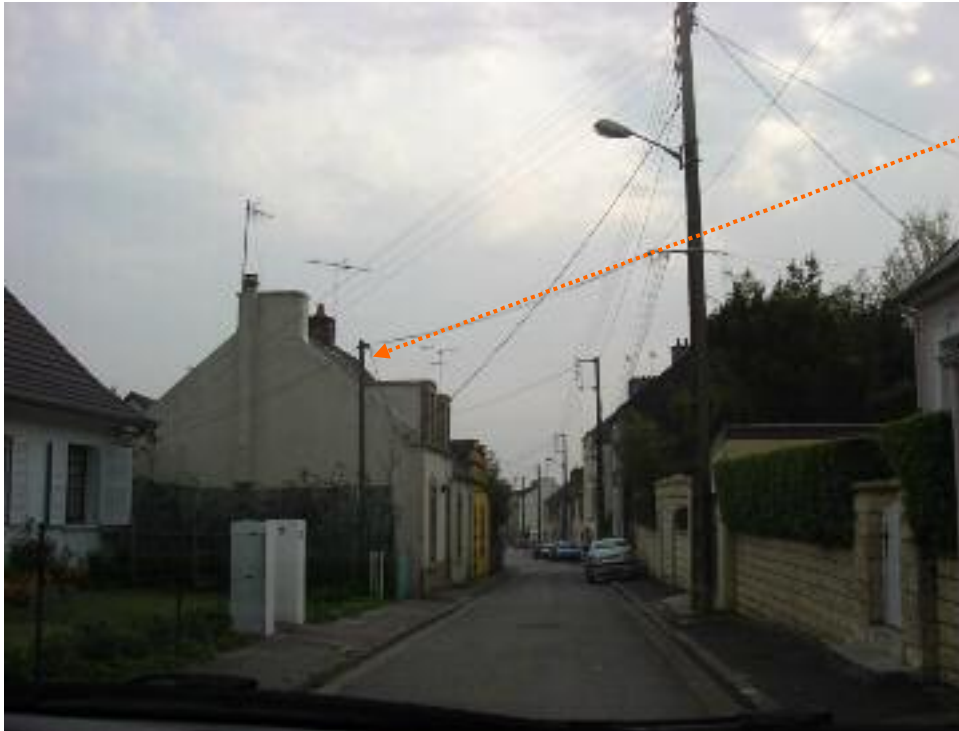
Poteau bois France Télécom
