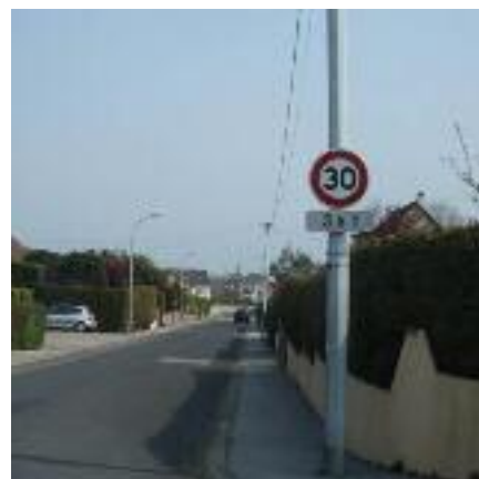
Desserte aérienne uniquement pour le téléphone par appuis métal en propre
