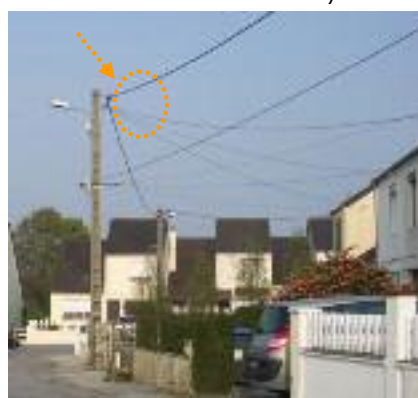
Raccordement aérien de 3 pavillons depuis un support béton (câbles EDF à conducteurs isolés)
