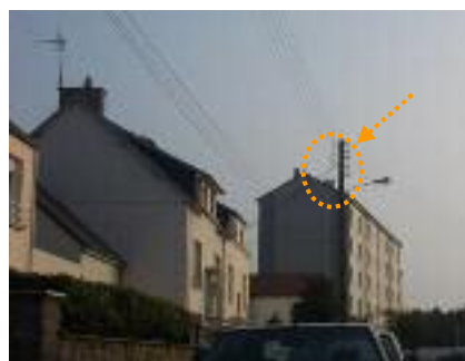
Raccordement aérien de 3 pavillons depuis un support béton (câbles EDF à conducteurs isolés)
